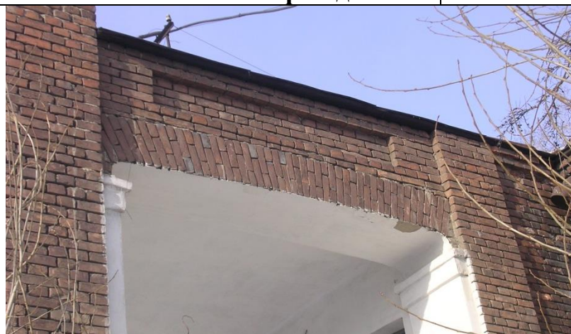
Перемычка навеса крыльца
